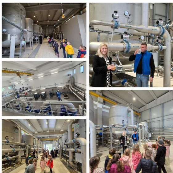
POSJET VODOCRPILIŠTU PITKE VODE U RAVNIKU
